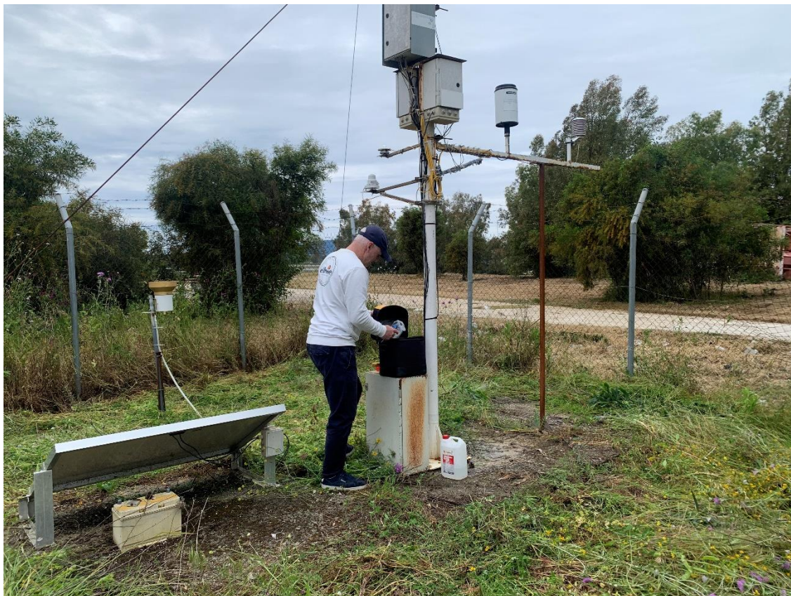
Εικόνα 1.2-1: Απο τις τεχνικές εργασίες στον σταθμό ΖΚΤ-2 στις 2/5/2023.
