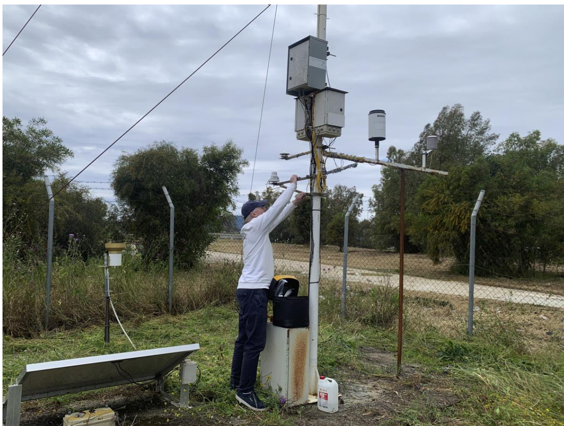
Εικόνα 1.2-2: Απο τις τεχνικές εργασίες στον σταθμό ΖΚΤ-2 στις 2/5/2023.
