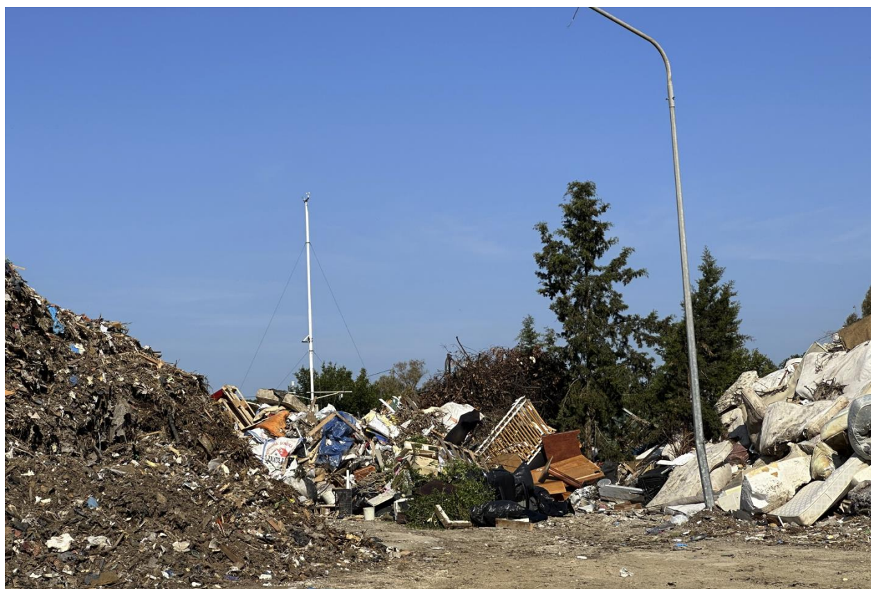
Εικόνες 1.2-5: Απο τις τεχνικές εργασίες στον σταθμό CRF-2 στις 7/5/2023.
