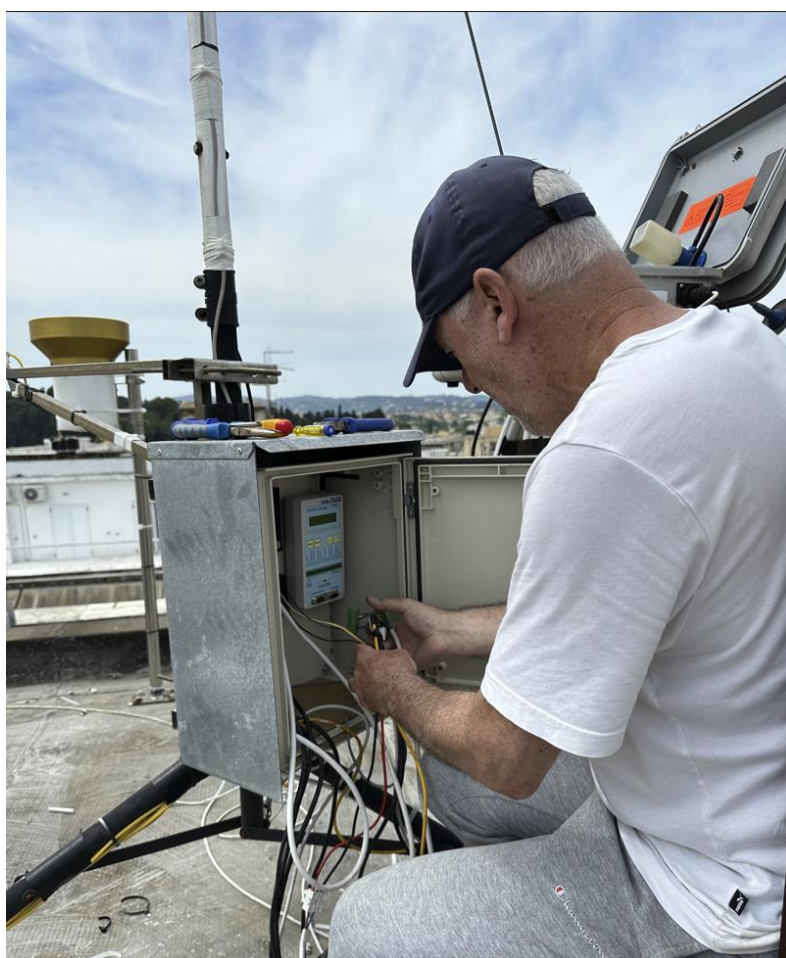
Εικόνες 1.2-11: Απο τις τεχνικές εργασίες στον σταθμό CRF-4 στις 8/5/2023
